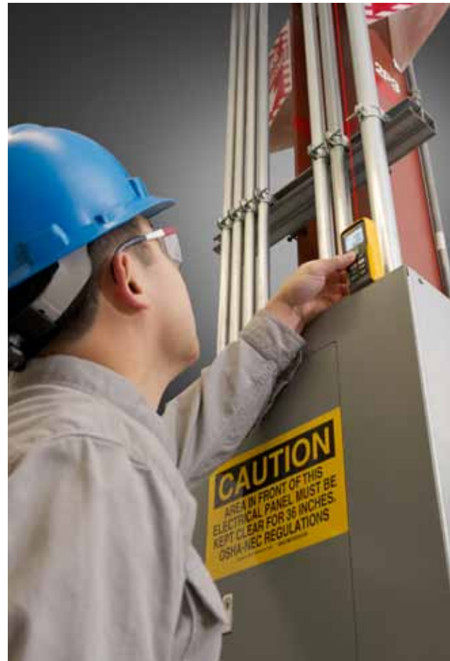
Mesure de la hauteur d'un plafond surélevé.
