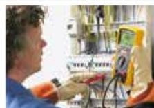
Isolationsprüfung an einer Unterverteilung
